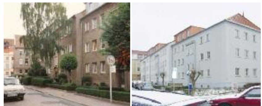
Seidenstraße 1 - 6 – vor und nach der Sanierung
