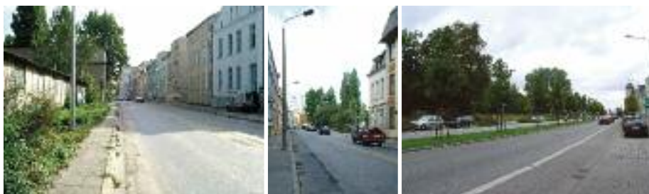
Verbindungsstraße Saarplatz bis Steintor 3. BA, hier die August-Bebel-Straße
