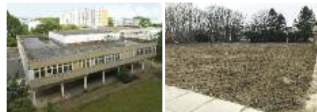
Schmarl: Rückbau Schmarler Zentrum
