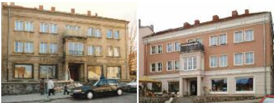
Sanierung Große Wasserstraße 6 – vor und nach der Sanierung
