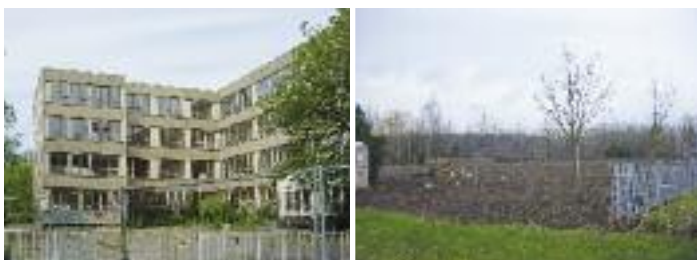
Schmarl: Abbruch der Grundschule St.-Jantzen-Ring
