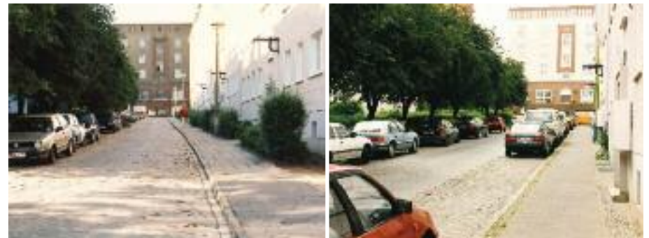
Koßfelderstraße – vor und nach der Sanierung
