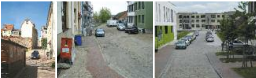
Küterbruch – vor und nach der Sanierung
