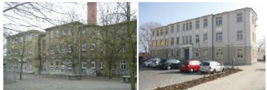
Schule Lindenstraße – vor und nach der Sanierung
