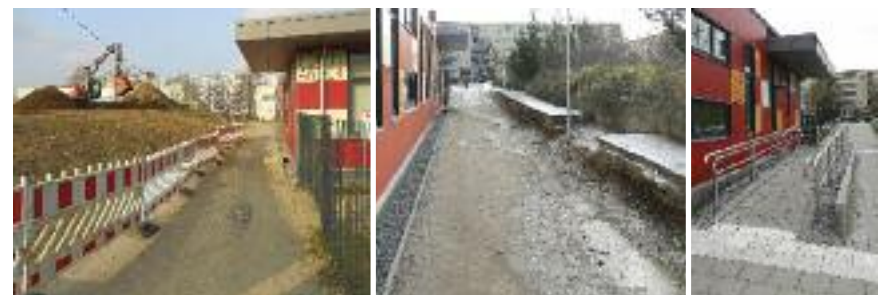
Toitenwinkel: Wegeverbindung O.-Palme-Straße/M.-L.-King-Allee – vor und nach der Sanierung
