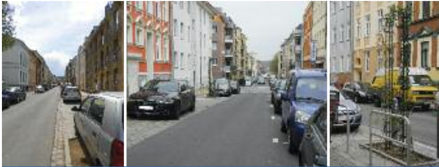
Sanierung Friedrichstraße (Süd)
