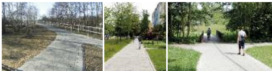
Evershagen: Erneuerung Gehwege A.-Kivi-Straße und Park
