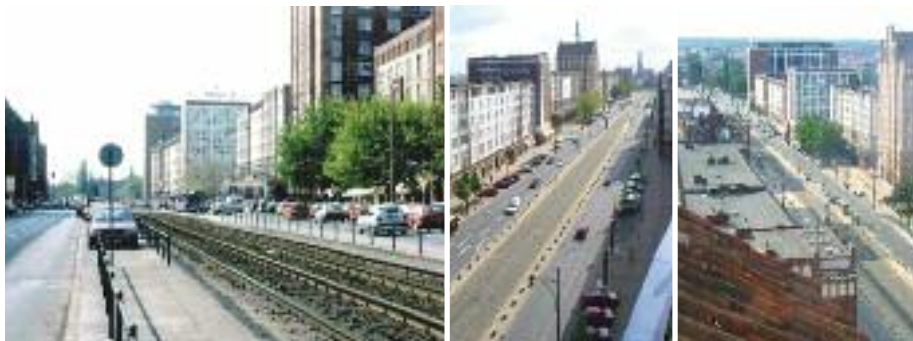
Umgestaltung Lange Straße – vor und nach der Sanierung
