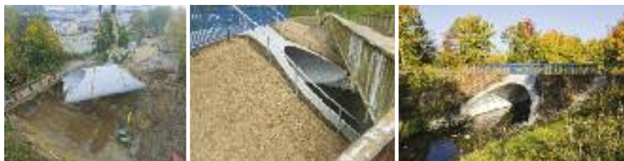
Schmarl: Neubau Gehweg und Brücke Klostergraben
