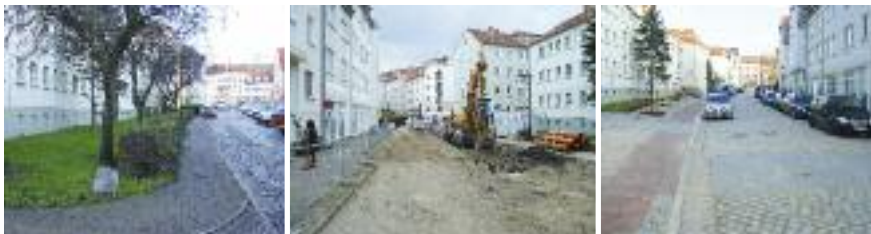
Fischbank (Ost) – vor und nach der Sanierung
