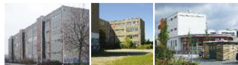
Groß Klein: Stadtteil- und Begegnungszentrum „Bürgerhus“
