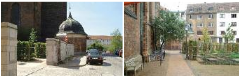
Umgestaltung Nikolaikirchplatz – nach der Sanierung
