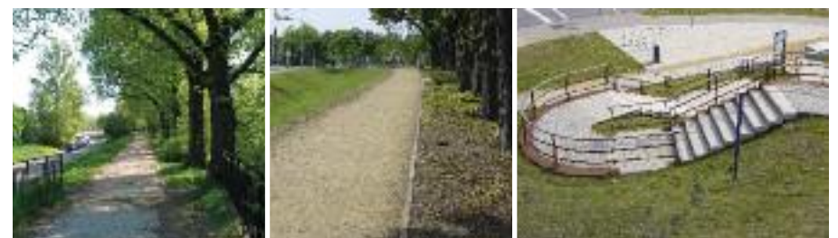
Fischerbastion – vor und nach der Sanierung
