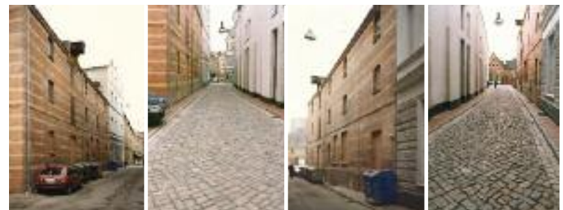
Kleiner Katthagen – vor und nach der Sanierung
