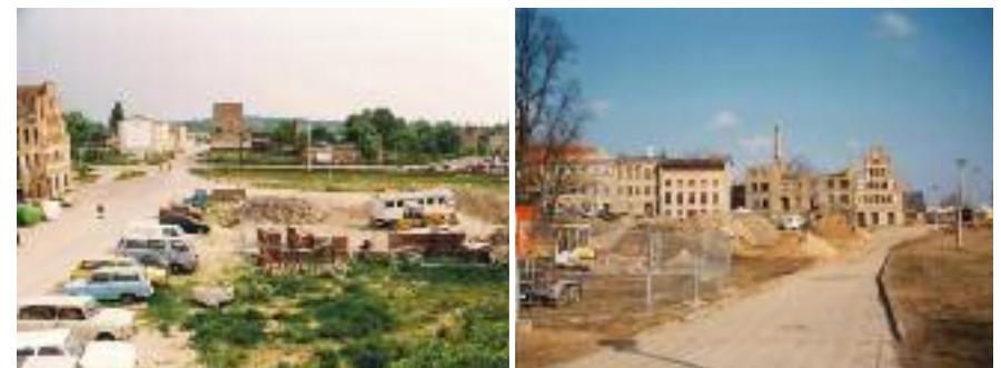
Freianlage und Spielplatz Gerberbruch – vor der Sanierung
