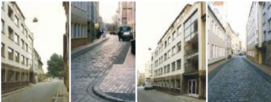
Rungestraße – vor und nach der Sanierung
