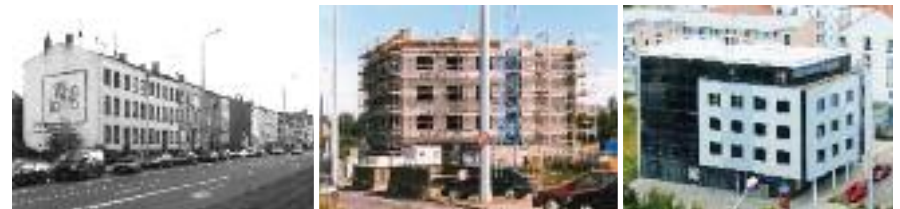
Neubau Bürohaus der RGS Am Vögenteich 26
