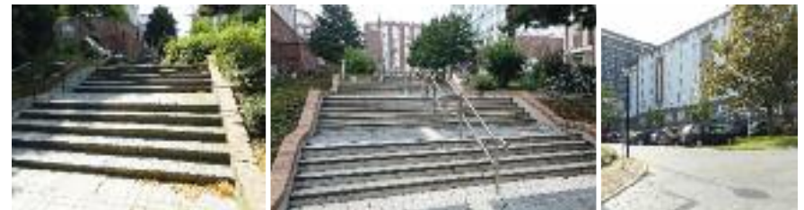
Grapengießer-/Badstüberstraße – vor und nach der Sanierung
