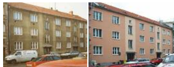
Stampfmüllerstraße 32 – vor und nach der Sanierung
