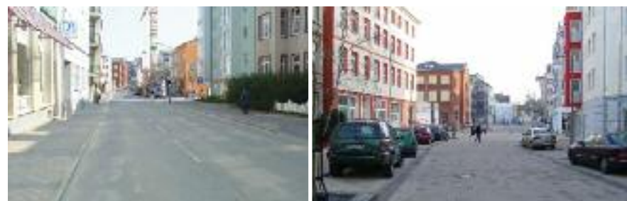
Umgestaltung Friedhofsweg – vor und nach der Sanierung
