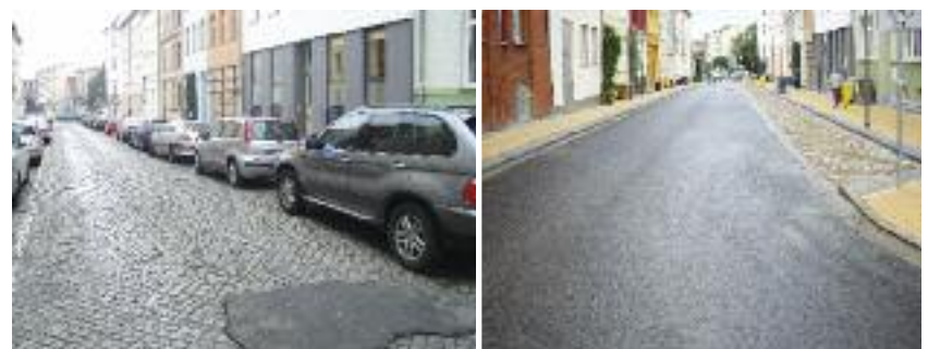
Patriotischer Weg (Ost) – vor und nach der Sanierung
