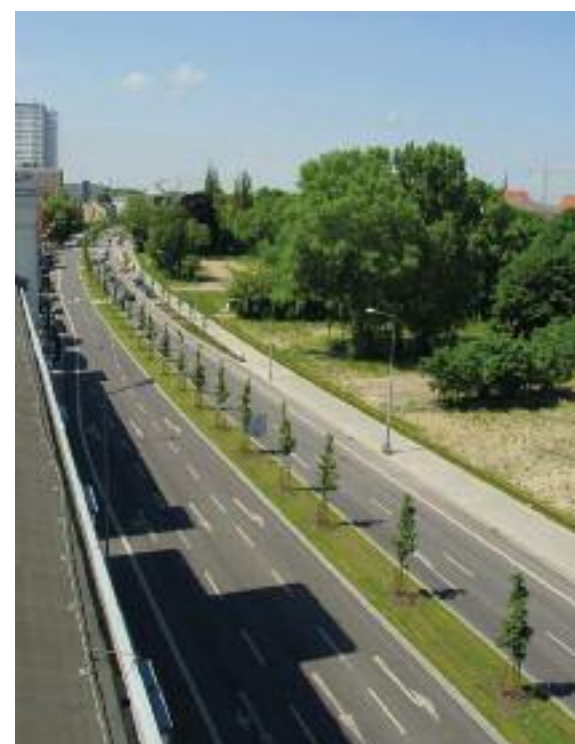
Verbindungsstraße Steintor–Am Vögenteich
