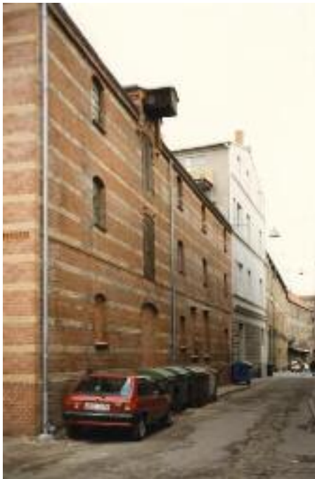
Kleiner Katthagen vor der Sanierung
