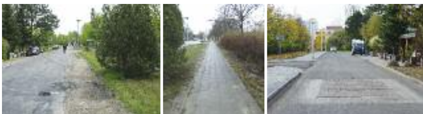
Groß Klein: F.-M.-Scharffenberg-Weg – vor und nach der Sanierung
