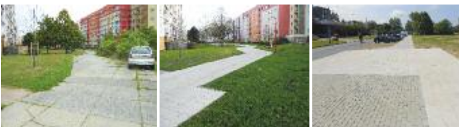
Groß Klein: Grünachse Quartier 6 – vor und nach der Sanierung
