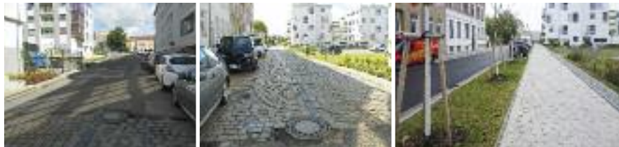
Bleicherstraße – vor und nach der Sanierung
