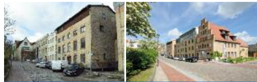
Oberhalb des Gerberbruchs – vor und nach der Sanierung
