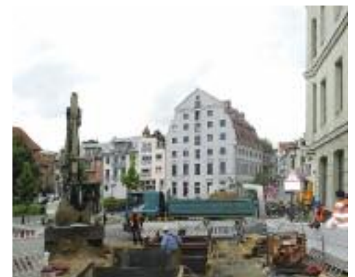
Tiefbauarbeiten am Wendländer Schilde...
