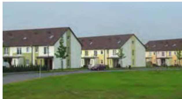
Typ Reihnhaus im Korl-Beggerow-Weg
