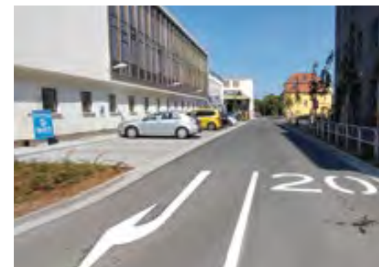
Bild links: Im Jahr 2024 wurden die Sanierungsarbeiten in der Lindenstraße fertiggestellt.
